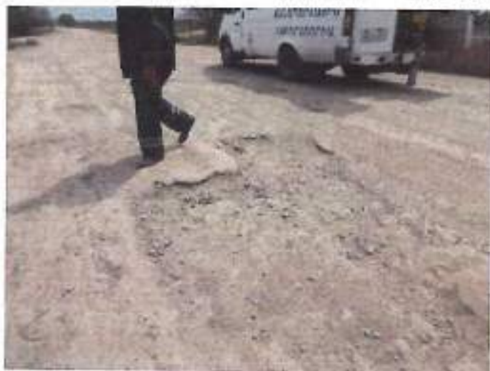
Նկար 12. Պարկերված է կամուրջի վրայի ուժեղ քայքայված ասֆալտը երևոնե ճանապարհը:
