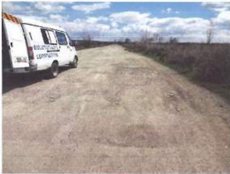
Նկար 8. պատկերված է 4-րդ պիկետում ասֆալտեությունն ուժեղ քայքայված ճանապարհի հատվածը:
