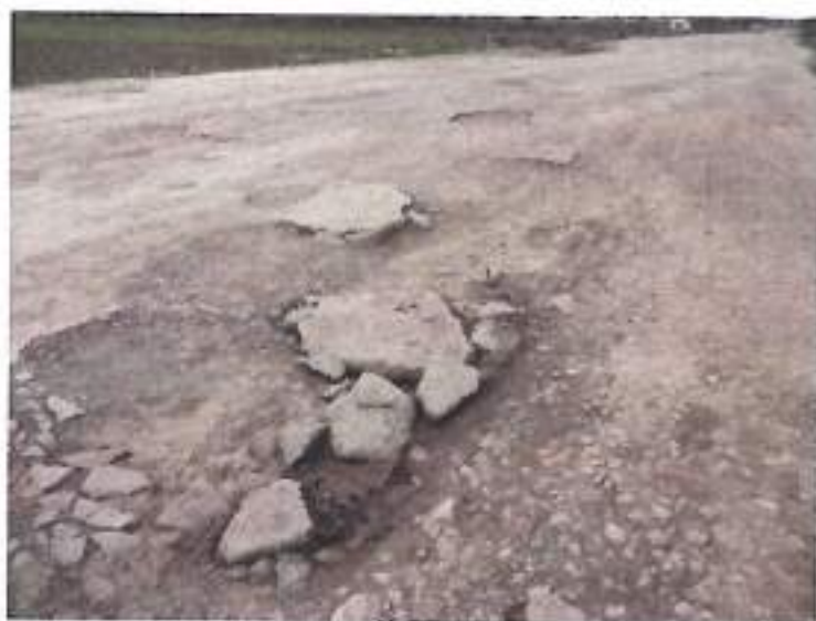
Նկար 14. Պարկերված է ուժեղ քայքայված աֆալքրեյոնե ճանապարհը 5-րդ պիկեյի տարածքում: Փոսերը փակելու նպատակով ավազա-գլաքարային գրունտ են լցրել ժամանակին:
