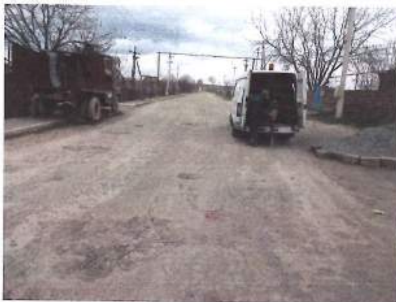
Նկար 20. Պարկերված է ուժեղ քայքայված ափալորեքոնե ծանապարիը 8-րդ պիկերի տարածքում և հորատման վայրը: С высоким содержанием
