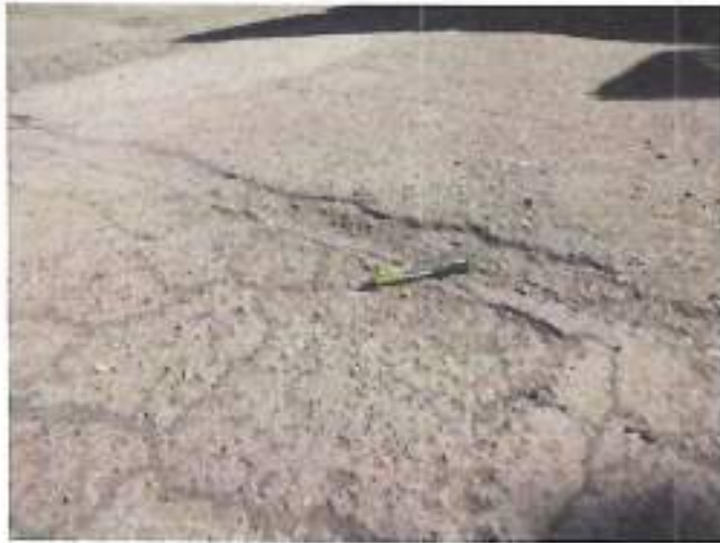
Նկար 4. պատկերված է 2-րդ պիկետում քայքայված ճանապարհի վրա առաջացած ճաքերը և նստվածքը:
