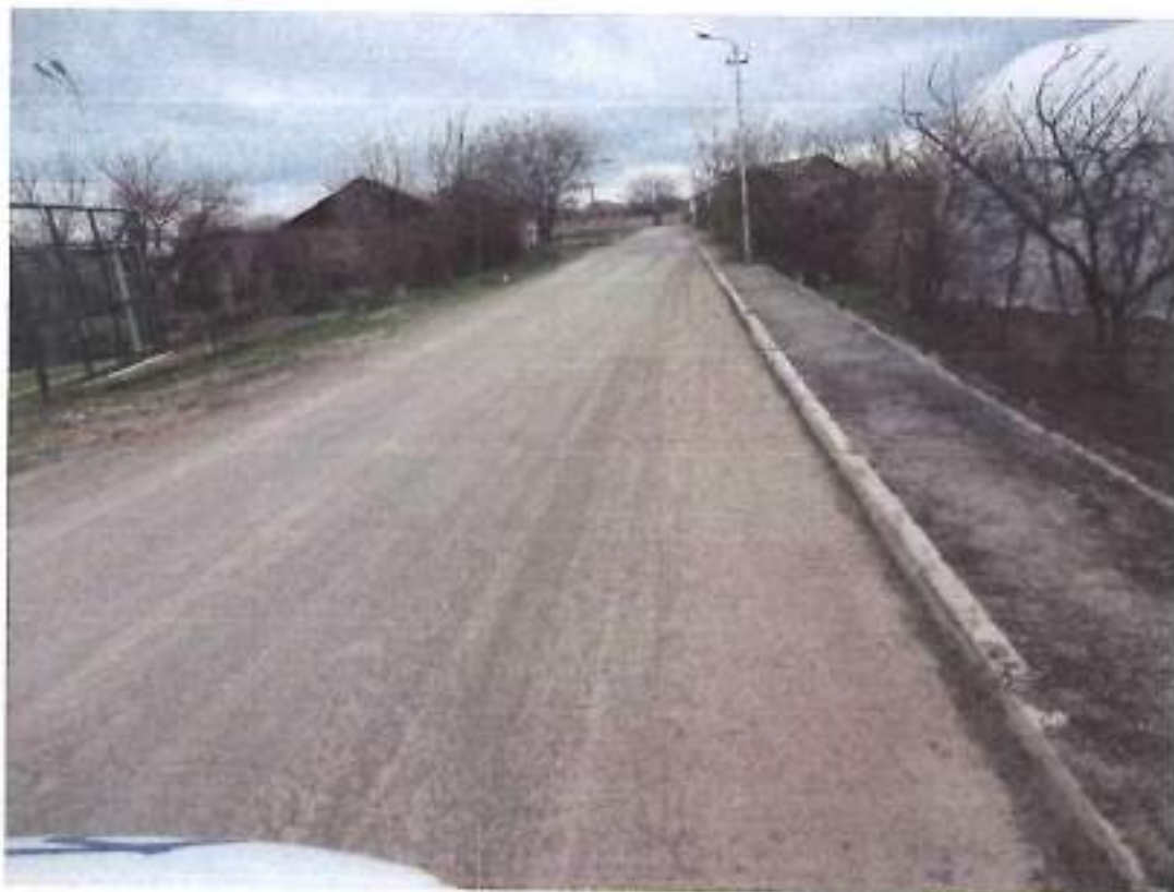
Նկար 23. Այստեղ պատկերված է թույլ քայքայված ասֆալտը երոնե ճանապարհը 9-րդ պիկեթի տարածքում:
