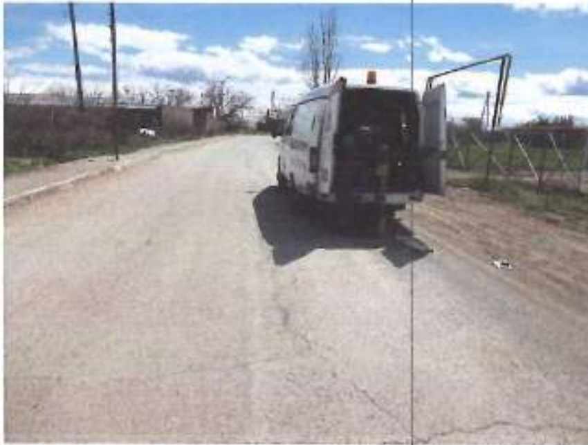
Նկար 30. Այսօրեղ պարկերված է թույլ քայքայված ասֆալտեղբերոնե ճառապարիղ 12-րդ պիկեղի քարաձեղում:
