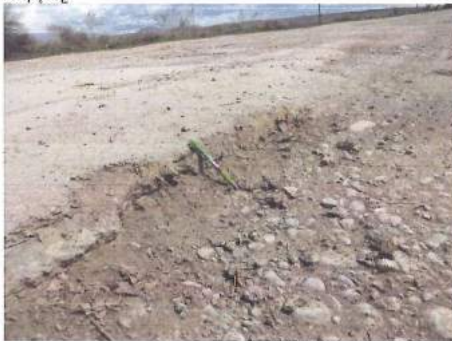
Նկար 9. Պատկերված է քայքայված ասֆալտեությունն շերտը և փոսը 4-րդ պիկետում, որը փակելու նպատակով լցրել են ավազա-գլաքարային գրունտով:
